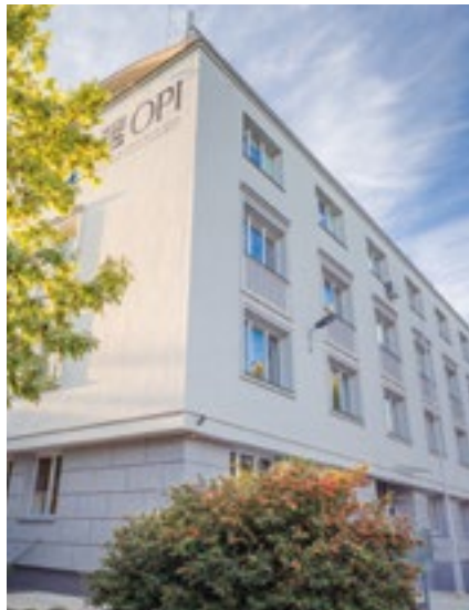
Budynek Ośrodka Przetwarzania Informacji – Państwowego Instytutu Badawczego. Fot. Marcin Zięba
